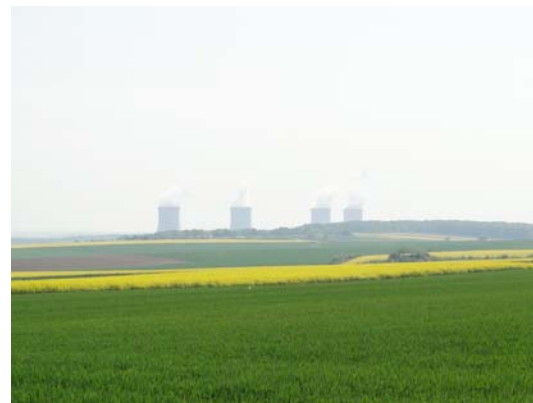
Centrale de Cattenom
